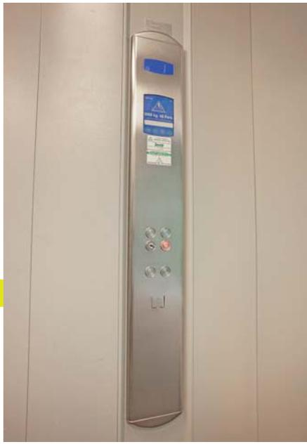
Le finiture delle pareti di cabina dipendono dalle caratteristiche dell'ambiente di lavoro e dalle condizioni di utilizzo. La lamiera può subire un trattamento speciale a resine epossidiche, può essere rivestita con materiali speciali e con diverse colorazioni, anche per utilizzi in ambienti chimici ed alimentari. Le botoniere si caratterizzano per semplicità d'uso e mantengono affidabilità nel tempo.
