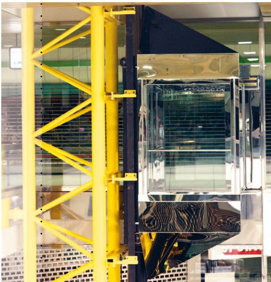
**Impianto panoramico in centro commerciale con:** cabina panoramica inox specchio e cristallo trasparente, pavimento in Granito, colonna di servizio in acciaio inox specchio, porte full-glass, carter prismatici superiori ed inferiori, protezione vano ai piani in acciaio inox specchio e cristallo trasparente, pulsanti antivandalo a sfioramento e illuminazione indiretta con logo cliente.
